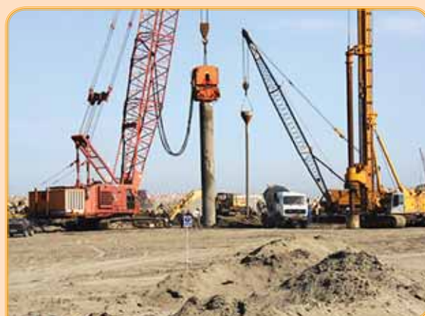
شروع و ساخت اسکله‌های جدید
