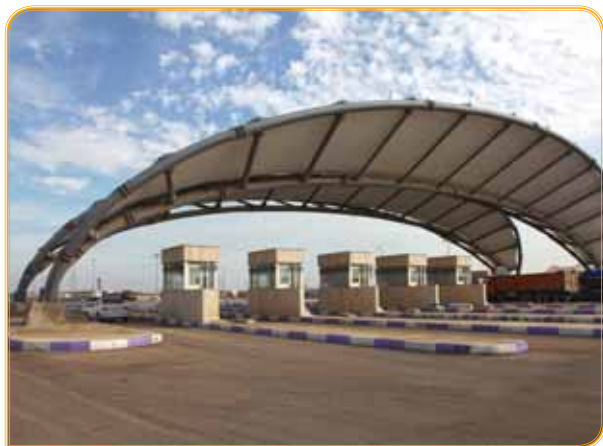
احداث معابر و جاده‌های دسترسی
