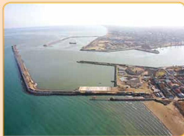
احداث دایک‌ها و موج‌شکن‌های شرقی و غربی
