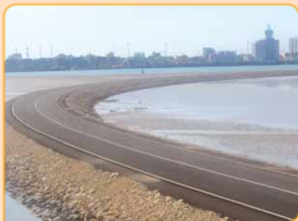
افتتاح راه ارتباطی مجتمع بندری نگین
